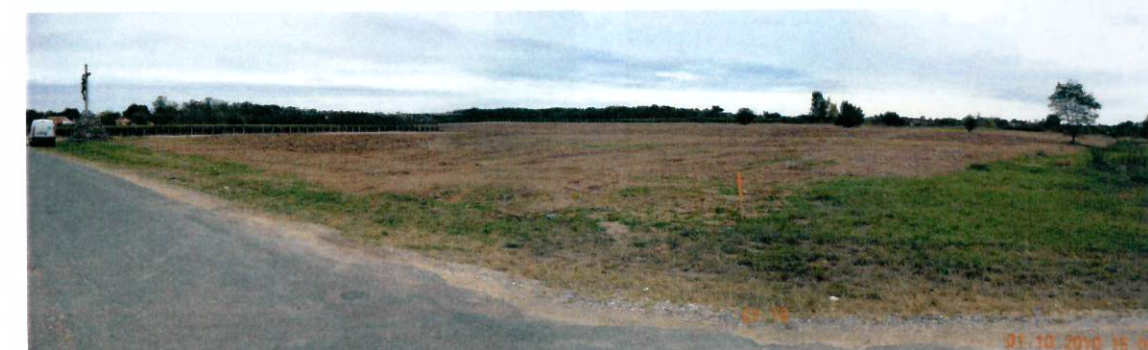
Vue de la couverture réalisée vers le sud
